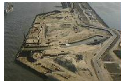
Bouw van de Maeslantkering (bron: beeldbank.rws.nl)
