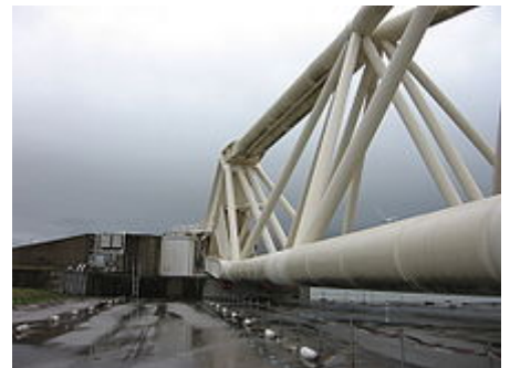
Detail met zicht op het scharnierpunt
