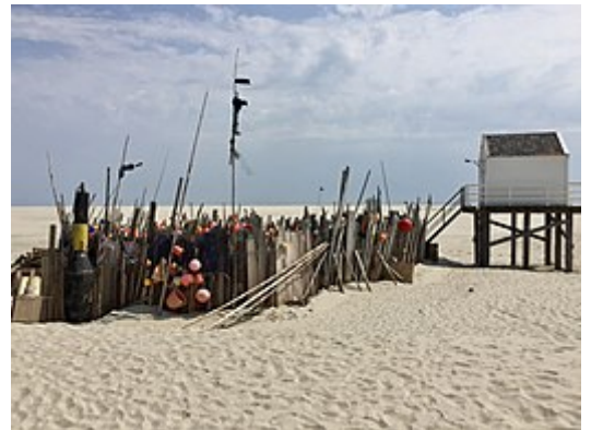
Het bouwwerk van dichtbij
